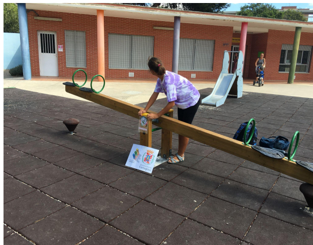
Balancín ya instalado en el patio de Infantil.
